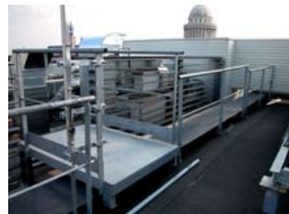
Passerelle et garde corps
